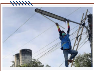
งานไฟฟ้า ซ่อมแซมไฟทาว ม.5
