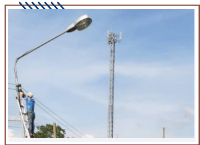
งานไฟฟ้า ซ่อมไฟทาว ม.1 บริเวณเส้นวัดไทรงาม - บริษัท ขุนศึก ทรานสปอร์ต จำกัด
