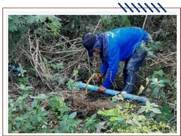
งานประปา ซ่อมแซมน้ำประปา ม.5
